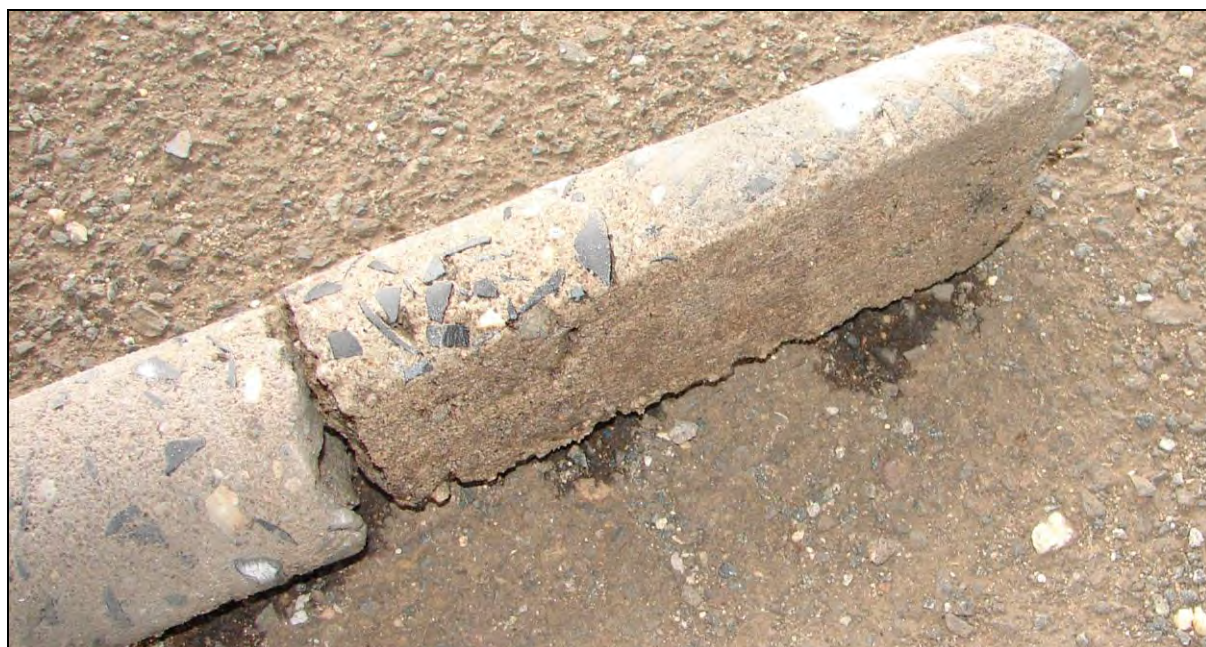
Foto 14: 2. nástupiště, základ sloupu 13 (Zpráva 1600 J 195 [11], Příloha 3, foto 51); beton spodní části základu z foto 13
