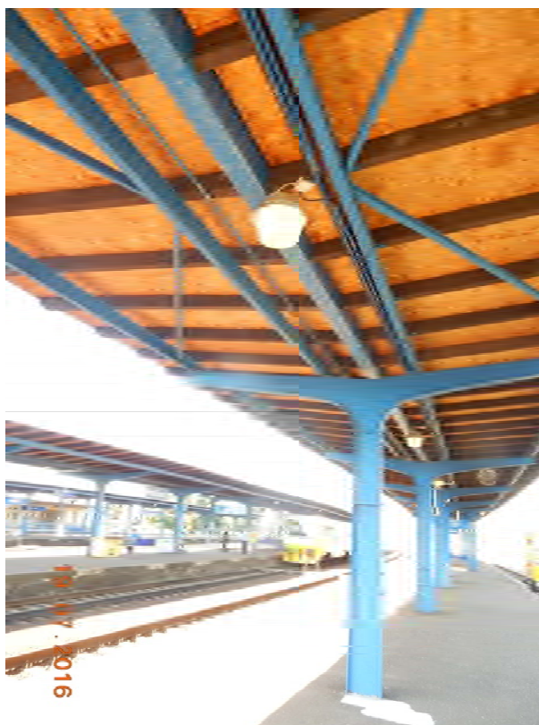
Obrázek 3 – konstrukce stávajícího zastřešení ostrovních nástupišť – část s jednou řadou sloupků
