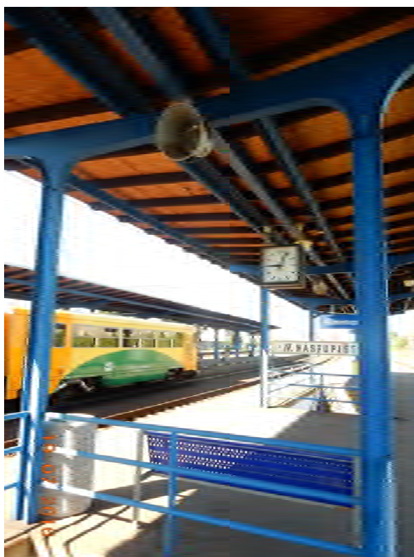
Obrázek 4 – konstrukce stávajícího zastřešení ostrovních nástupišť – část s dvěma řadami sloupků
