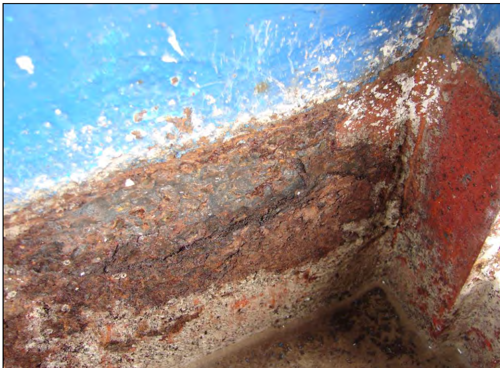
Obr. 57: Sloupy zastřešení nástupišť, 3. nástupiště, sloup 4; sloup po částečném sejmutí korozních zplodin
