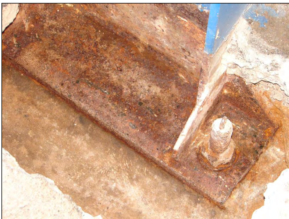
Obr. 65: Sloupy zastřešení nástupišť, 4. nástupiště, sloup 13; koroze kotvení je povrchová s počáteční tvorbou korozních zplodin bez zjevného úbytku tloušťek plechů (písek v oblasti kotvení byl suchý)
